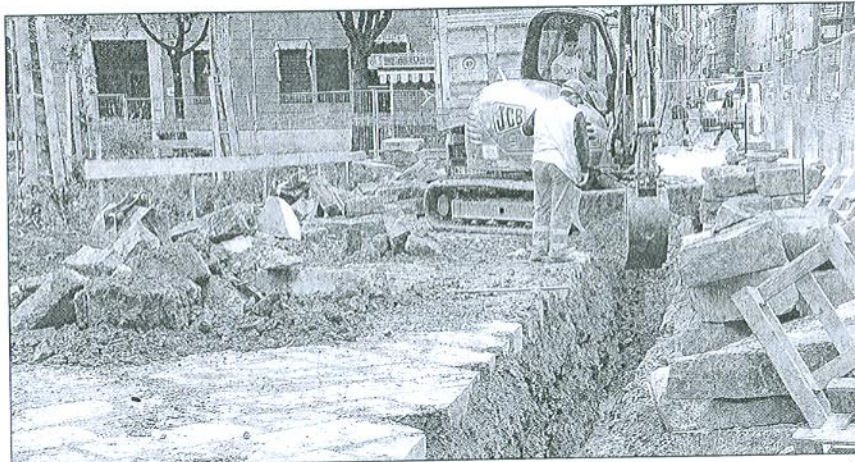
Le immagini scattate dal Comitato Cosapu al cantiere aperto in piazza Venezia
